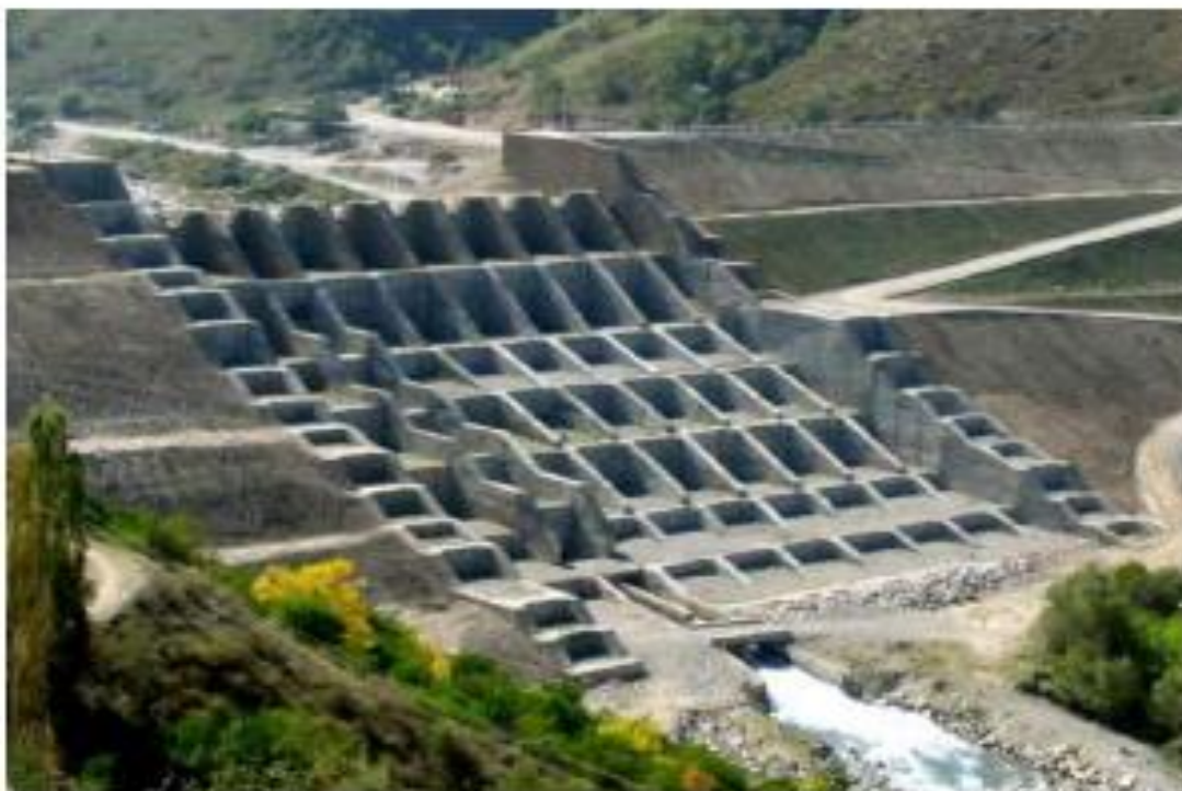
Үлкен Алматы өзеніндегі сел ұстағыш ұяшықты плотина
